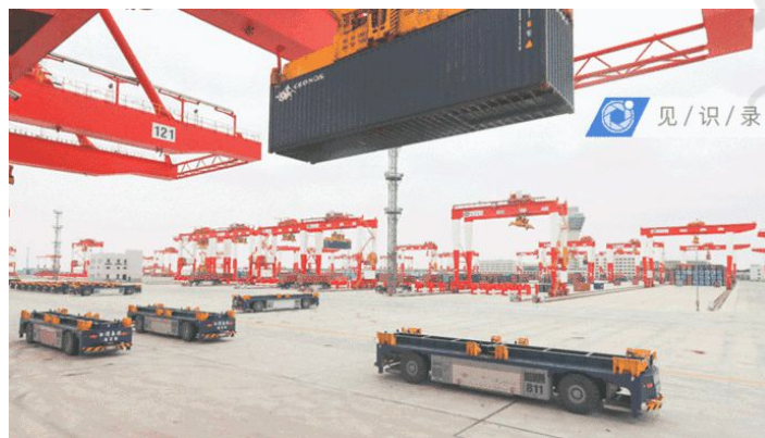
上海港洋山四期双箱自动化轨道吊车
